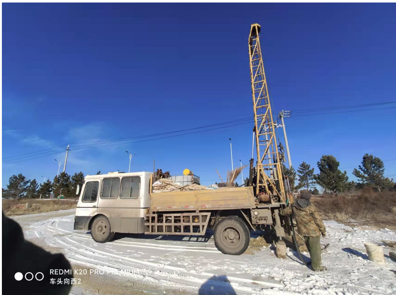
钻孔 zk2 现场工作照片
