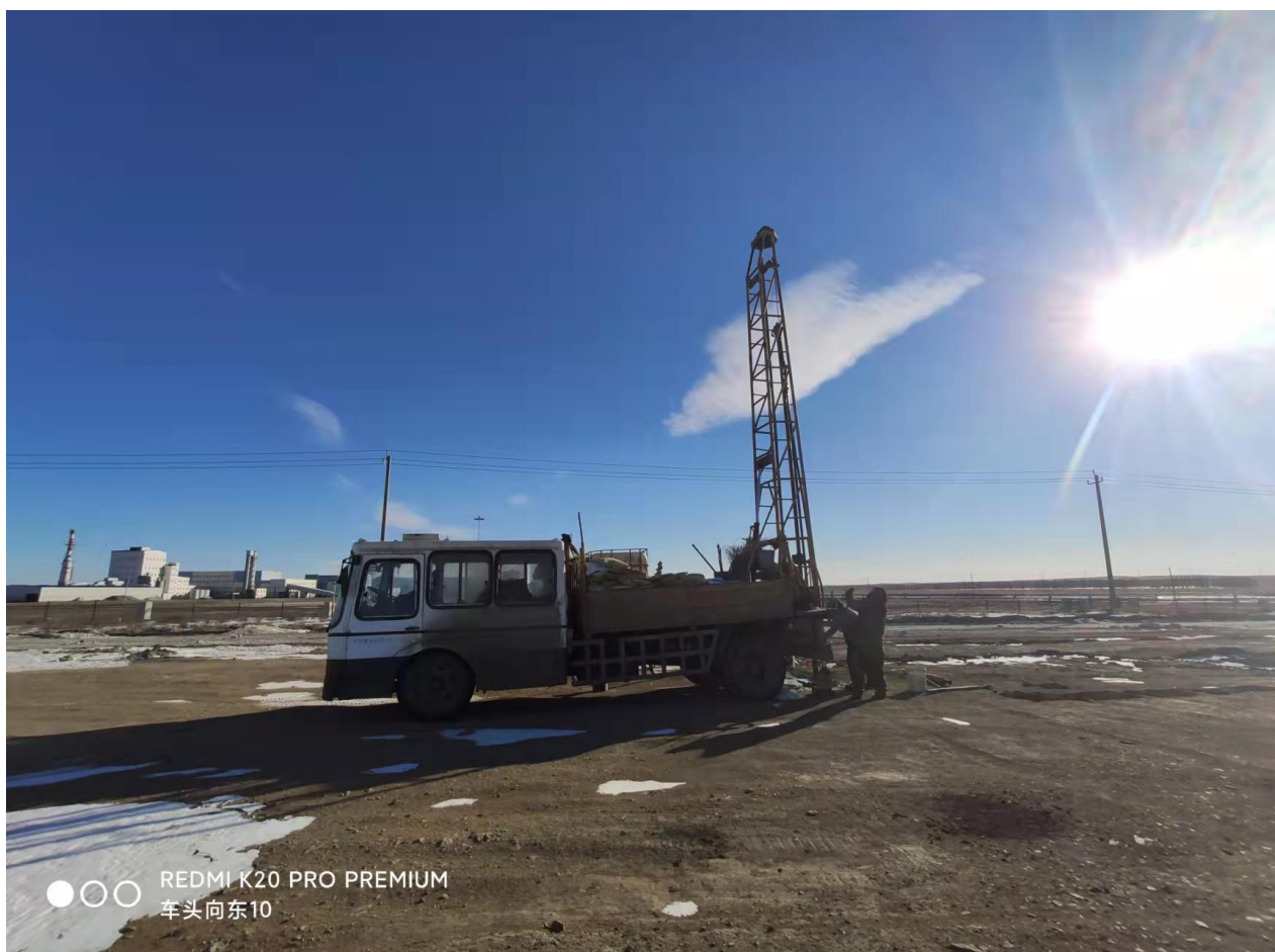
钻孔 zk7 现场工作照片
