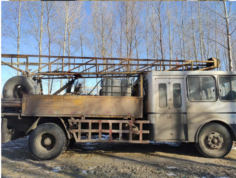
钻孔 zk12 现场工作照片
