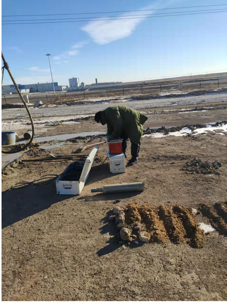
钻孔 zk13 现场工作照片
