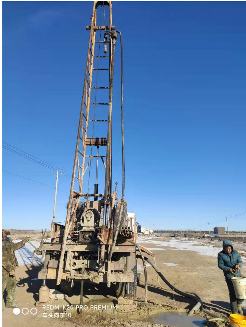
钻孔 zk1 现场工作照片
