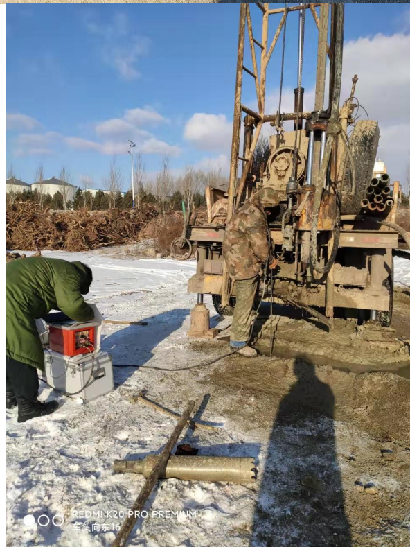
钻孔 zk14 现场工作照片
