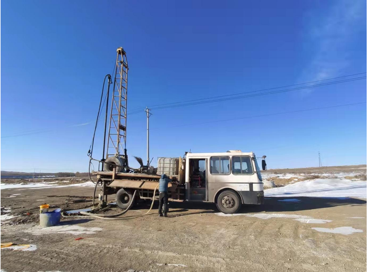
钻孔 zk3 现场工作照片
