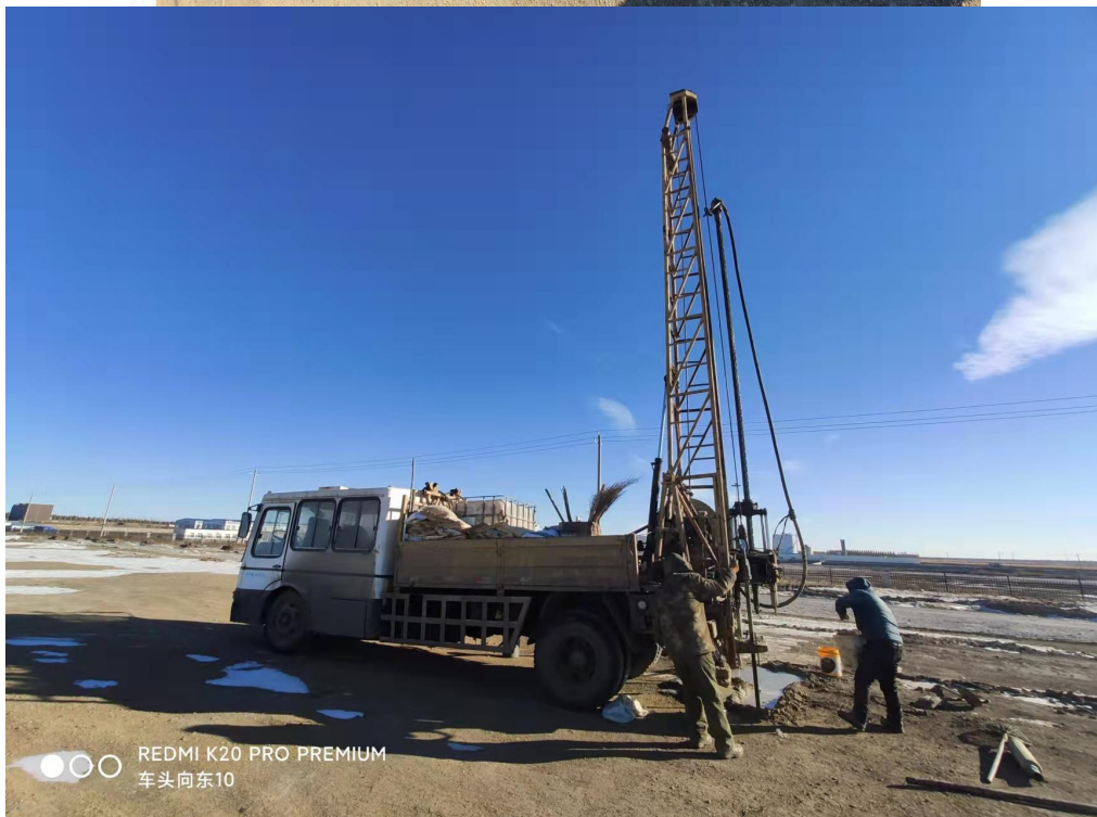
钻孔 zk10 现场工作照片
