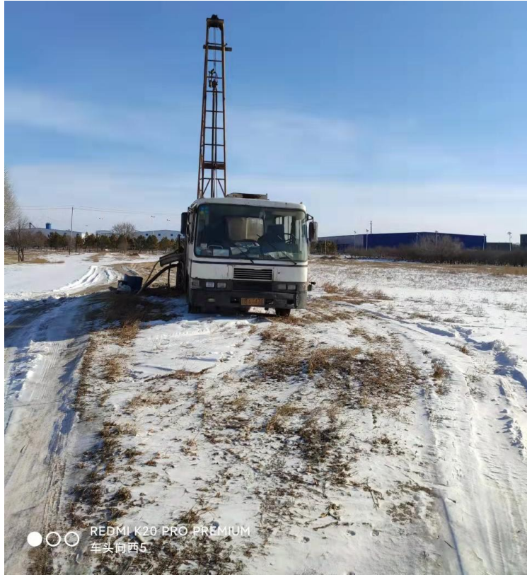
钻孔 zk5 现场工作照片
