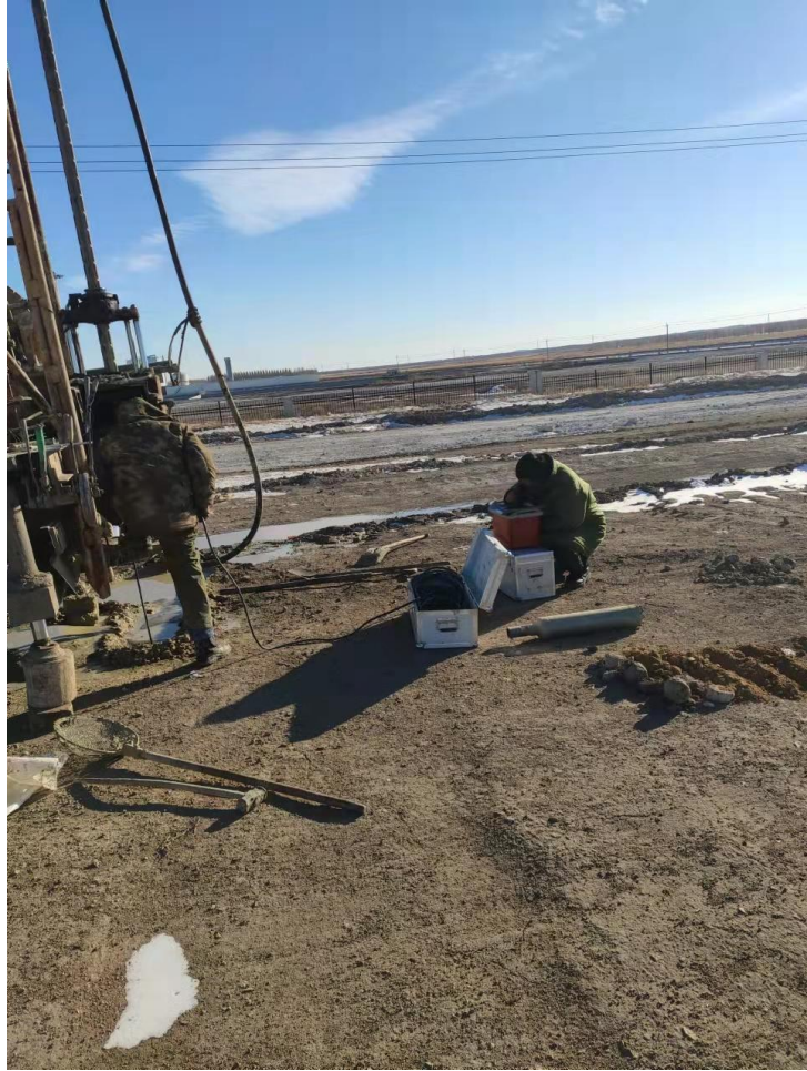
钻孔 zk17 现场工作照片
