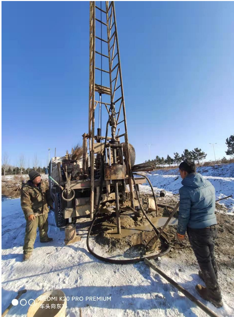
钻孔 zk18 现场工作照片
