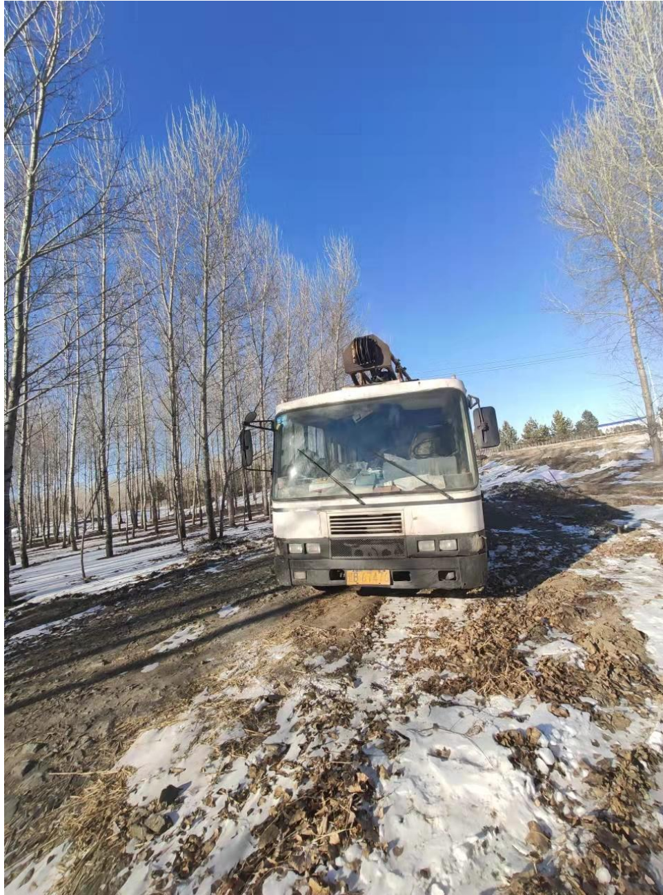
钻孔 zk8 现场工作照片
